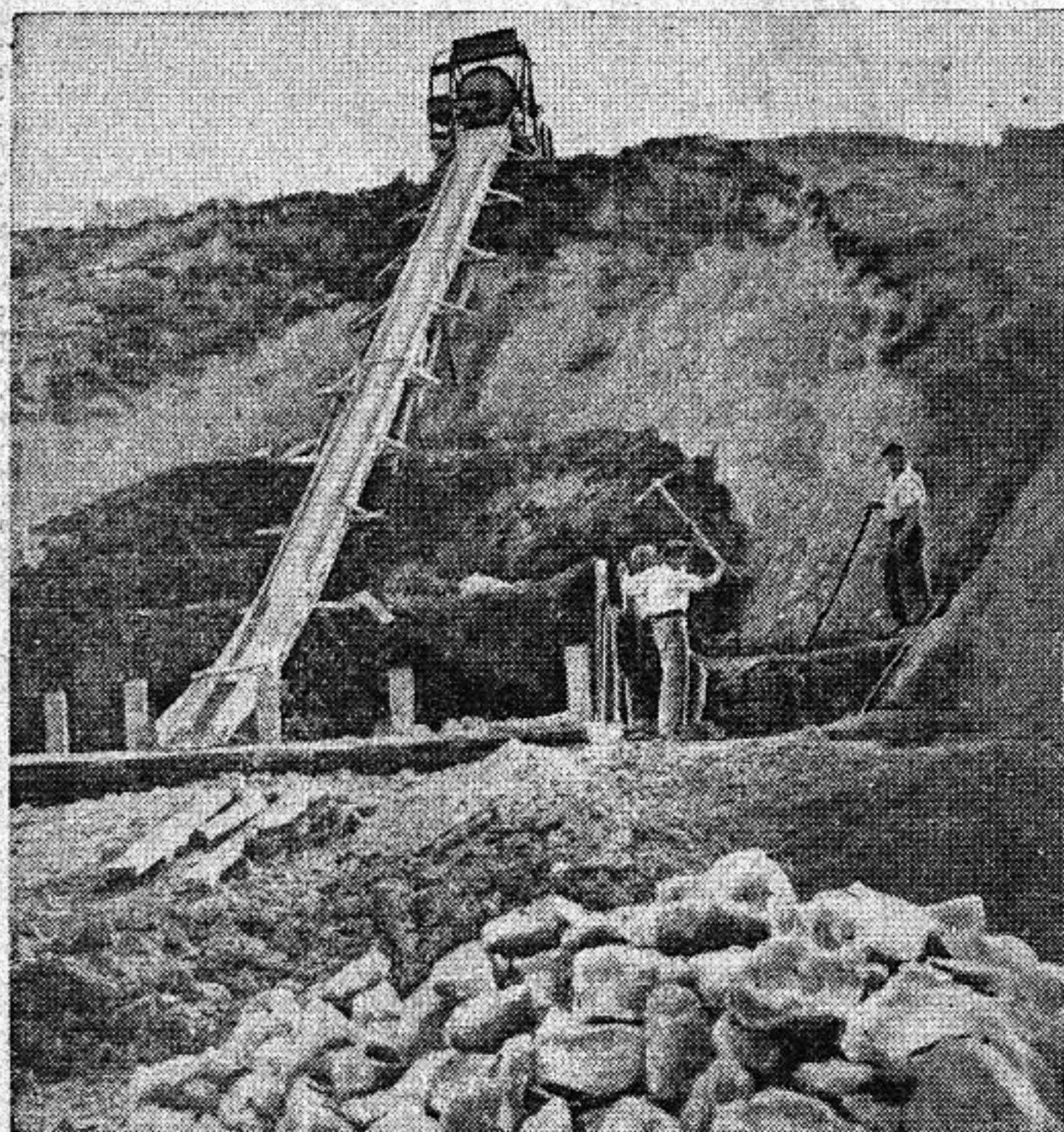
Les travaux d'aménagement de la butte du Chapeau-Rouge
